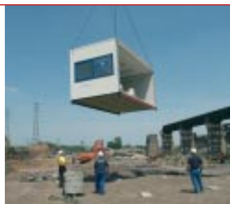
Installation du chantier
